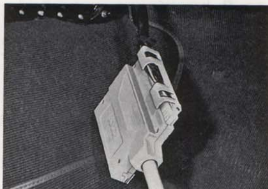
Bild 2—14. Testinstrument anslutet till ledningsmatta
